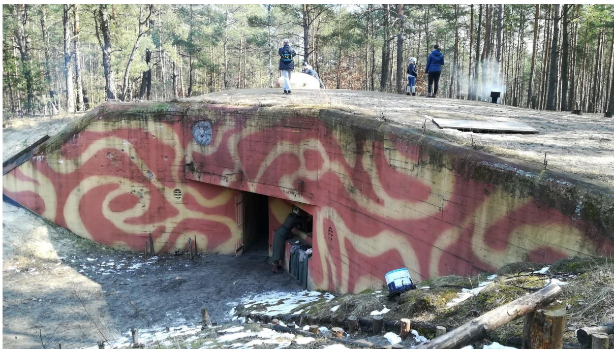
ryc. 10 Bunkry w Dąbrowieckiej Górze
